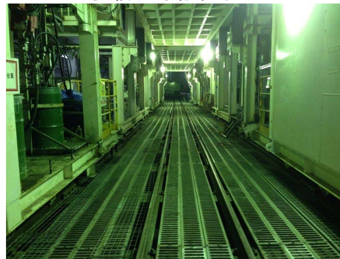
後続台車設置状況
