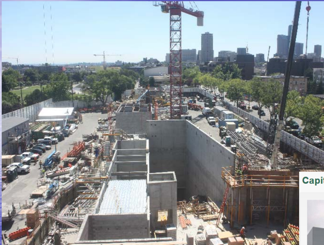
U230工区 現在の様子
