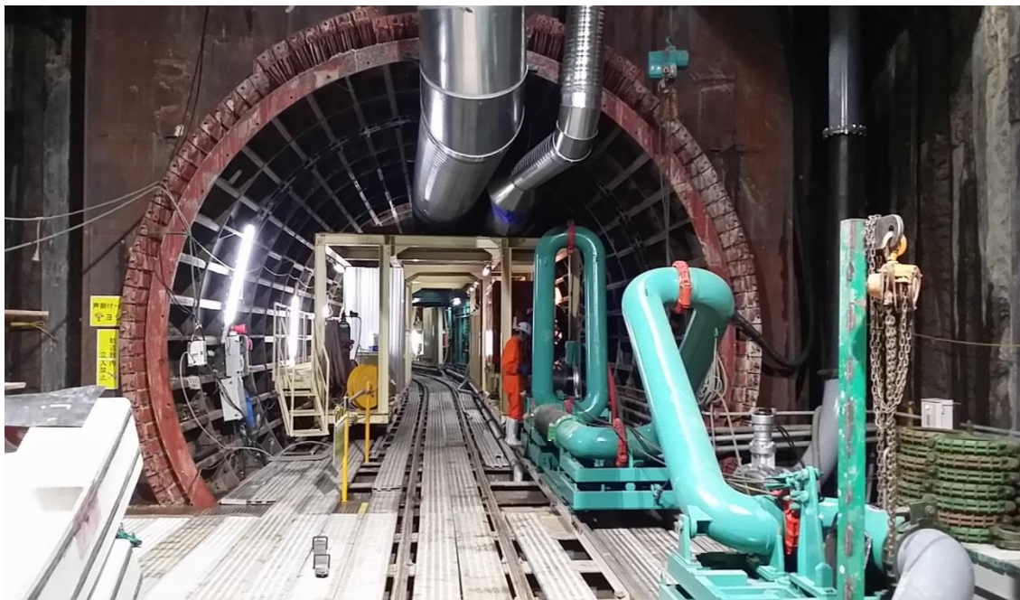
初期掘進時 (坑口部)
