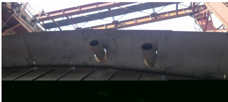
裏込め注入管
