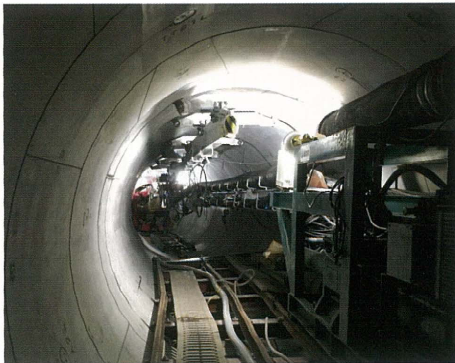
シールド坑内(掘削・裏込め)
