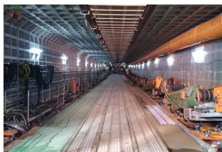
施工中の坑内状況
