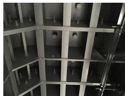
完成状況とミニパッカー注入孔(タック撮影)
