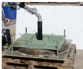
ミニパッカー注入状況
