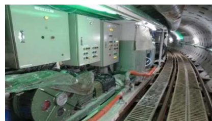
写真-1 測点 3 付近の坑内
