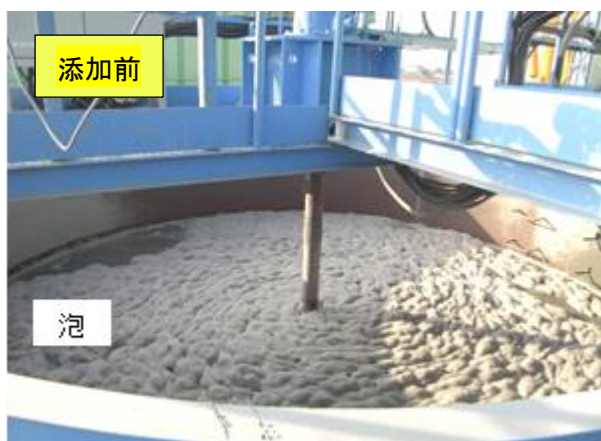
気泡シールド工法の掘削土流体輸送での FT-01 消泡効果(調整槽)
