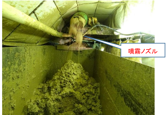
気泡土への添加(ノズル噴霧)状況
