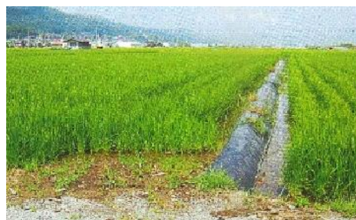
水田の嵩上げ盛土
