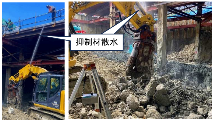
抑制材散水の粉じん状況
