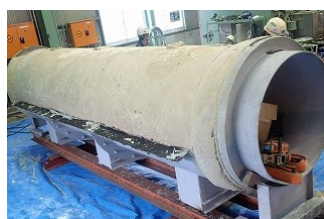
硬化後の外枠取外し (空隙の無い充填を確認)
