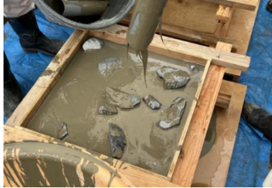
プレパグドコンクリート充填状況
