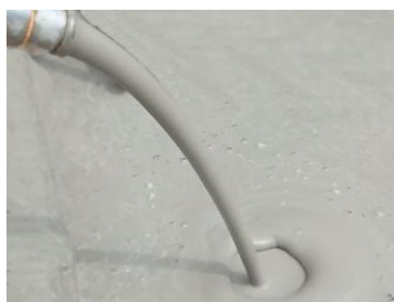
先端混合後エアモルタル
