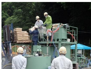
モルタル混練状況
