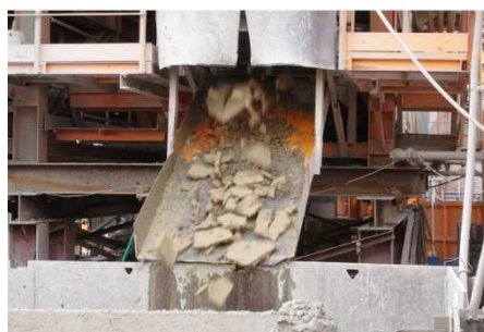
脱水ケーキ排出状況
