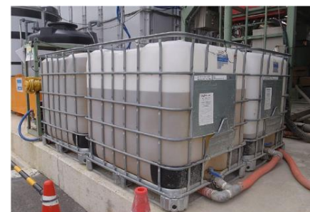
コンパクトなTG スコール-L ヤード (1m 3 コンテナ4基)
