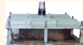
ミニパッカー注入状況
