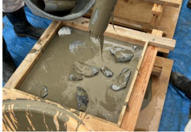
プレパグドコンクリート充填状況
