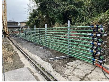
長距離圧送配管
